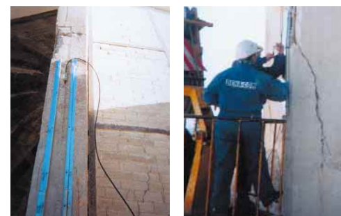
Pose de cordes optiques Osmos sur les poteaux du dôme
