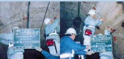
Installation des cordes optiques sur un profil en travers, à raison d'un ensemble Osmos tous les 25 mètres
