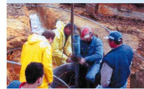
Descente de la «Chenille optique» dans son forage
