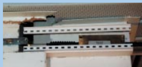
Surveillance de joints avec extensomètre
