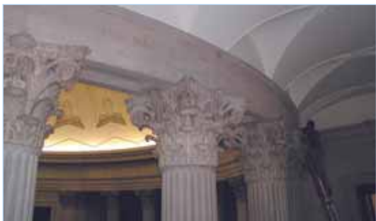
Le cheminement du réseau optique sur la rotonde est totalement invisible.
