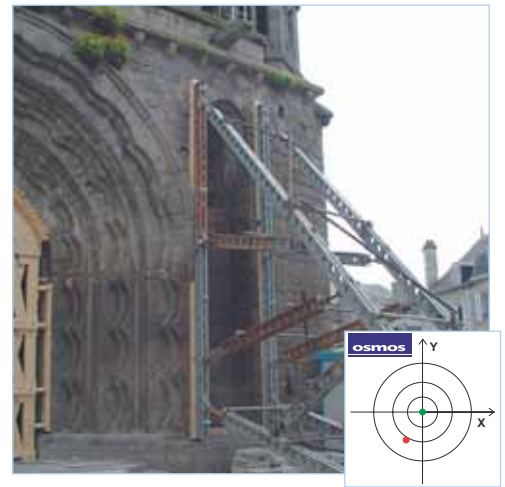
Les hautes fréquences d'acquisition des cordes optiques ont incité les entreprises à intervenir sur l'édifice avec toutes les précautions requises.
