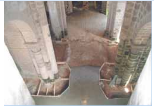
Les hautes fréquences d'acquisition des cordes optiques ont incité les entreprises à intervenir sur l'édifice avec toutes les précautions requises.
