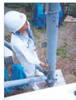
Montage d'un extensomètre optique par un technicien de JGC.
