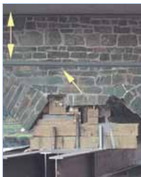
Soutènement d'urgence du pont et corde optique sous protection (voir flèche)
