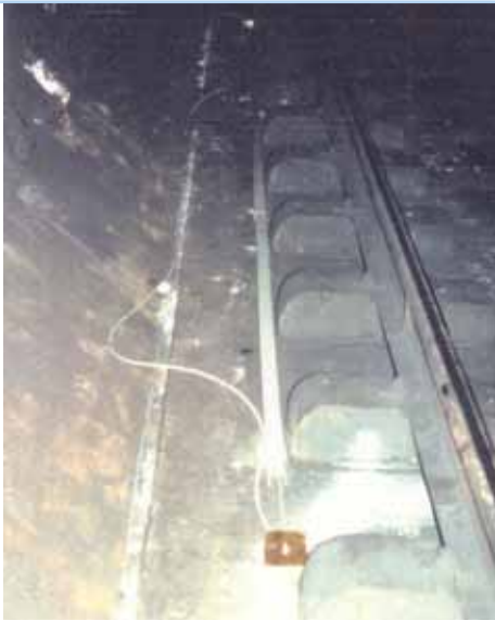
La longueur d'une corde optique doit être supérieure au Z du tunnel pour caractériser son comportement de poutre sur appui élastique.
