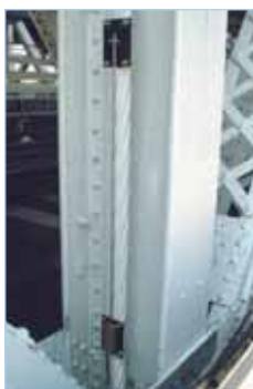
Extensomètre optique sur une suspente.
