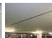
< Ouverture de fissure réversible sous passages répétés de véhicules.
