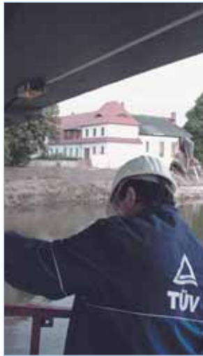
Pose d'une corde optique par un technicien du TÜV.
