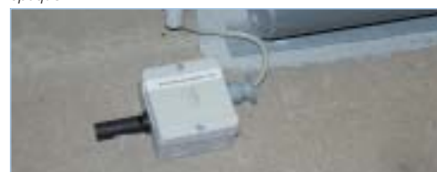
Détecteur de crue au droit d'une des cordes optiques
