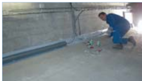
Réglage de la corde optique avant capotage définitif
