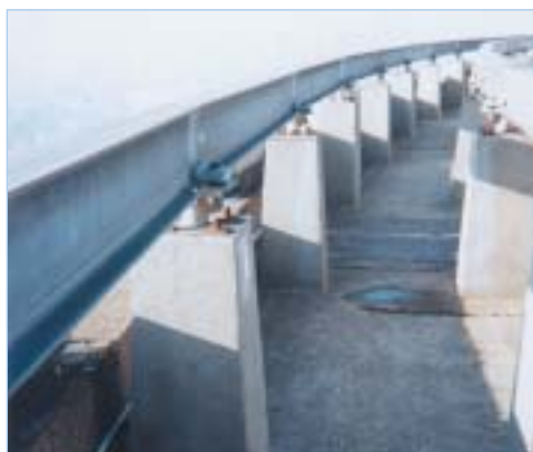
Chemin de roulement, rail extérieur/rail intérieur
