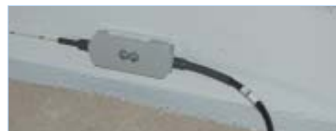
Détail d'une corde optique au niveau de la connexion au réseau optique
