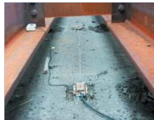
Corde optique sur la table de compression d'une travée
