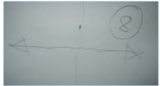
Repérage des zones fissurées avant l'installation
