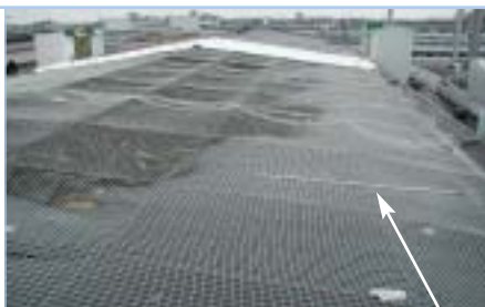
Filet de protection en toiture après incendie et corde optique montée sur entretoise
