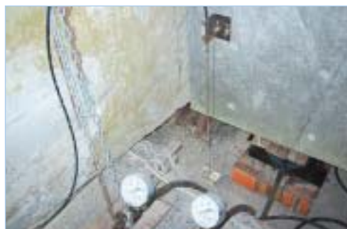
Extensomètre optique au droit d'un appui pendant opération de vérinage
