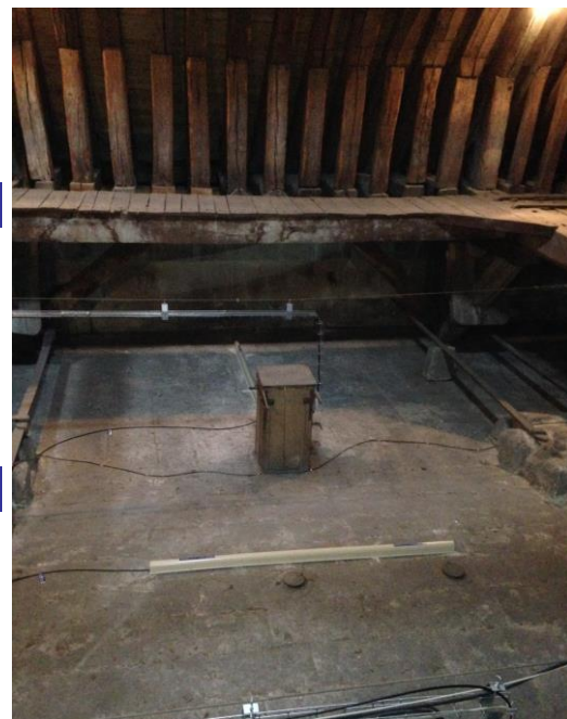
Cordes Optiques sur les voûtes de la nef, dans les combles
