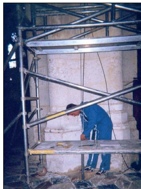
Descente d'une Corde Optique dans un forage
